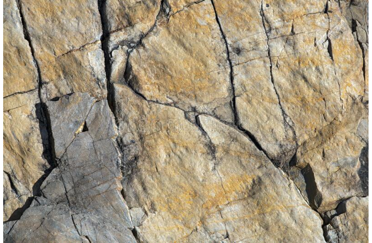
Трещины во вмещающей кристаллической породе
